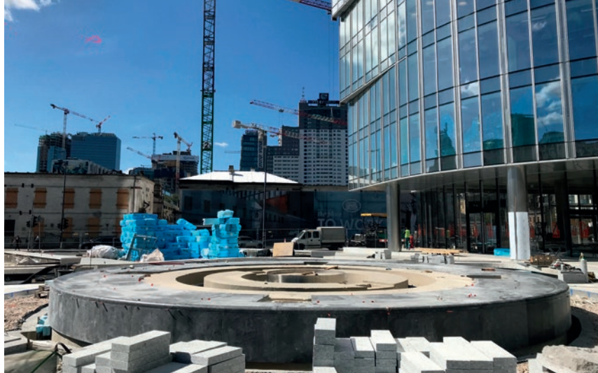
Fot. 3. Widok na budowaną fontannę na placu od strony ul. Prostej
