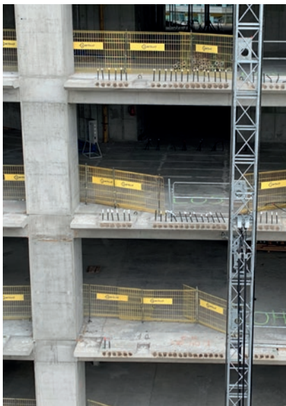
Fot. 10. Widok wsporników przeznaczonych do mocowania fasady
