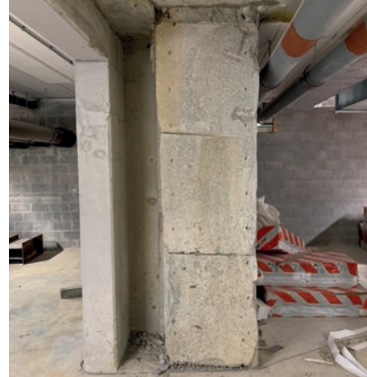
Fot. 7. Widoczne przecięcie ściany szczelinowej wybudowanej pomiędzy dwoma działkami budowlanymi
