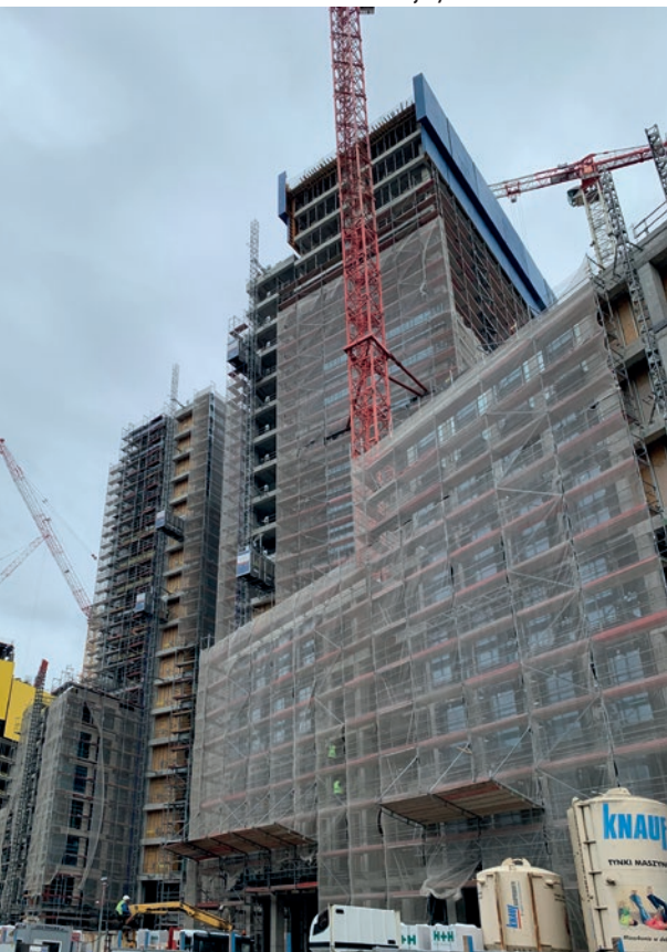
Fot. 5. Kompleks Varso w trakcie budowy widziany od strony ulicy Chmielnej, na pierwszym planie dwa niższe budynki, w tle wznoszona najwyższa wieża
