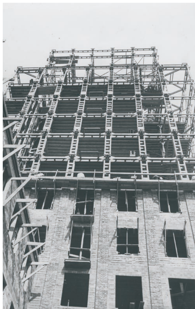
Rys. 3. Widok na szkielet konstrukcji stalowej „Prudential” podczas budowy, lata 30-te (NAC)
