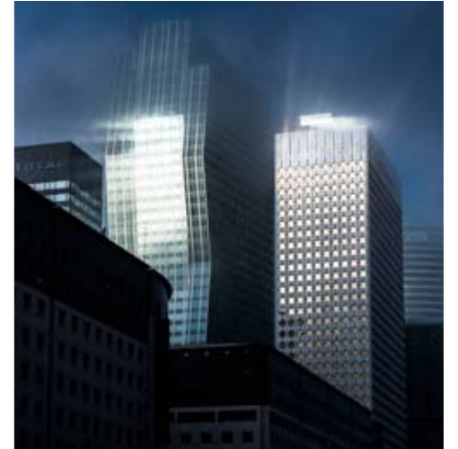
Rys. 3. Mercury City Towers w Moskwie. Typ układu konstrukcyjnego tego wieżowca określić można jako trzonowo-słupowy. Elewacja zewnętrzna wykonana z potrójnych szyb zespolonych została pokryta miedzianą powłoką refleksyjną.
